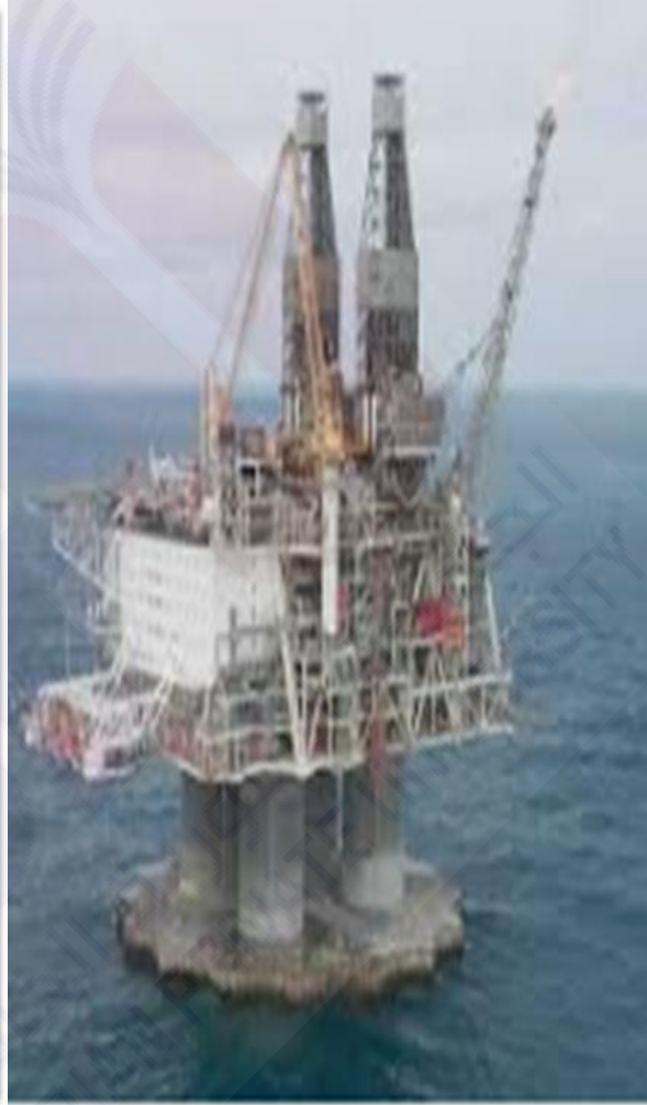
الشكل (1-5) منصات بحرية ذات أرجل أسطوانية الشكل (1-6) المنظر من داخل الأرجل
