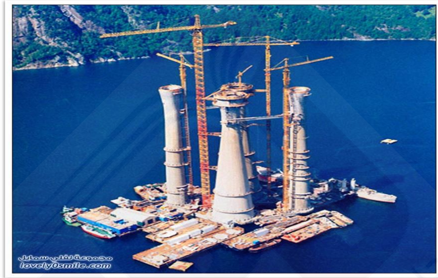
الشكل (1-7) بناء قوائم المنصات الإسمنتية
