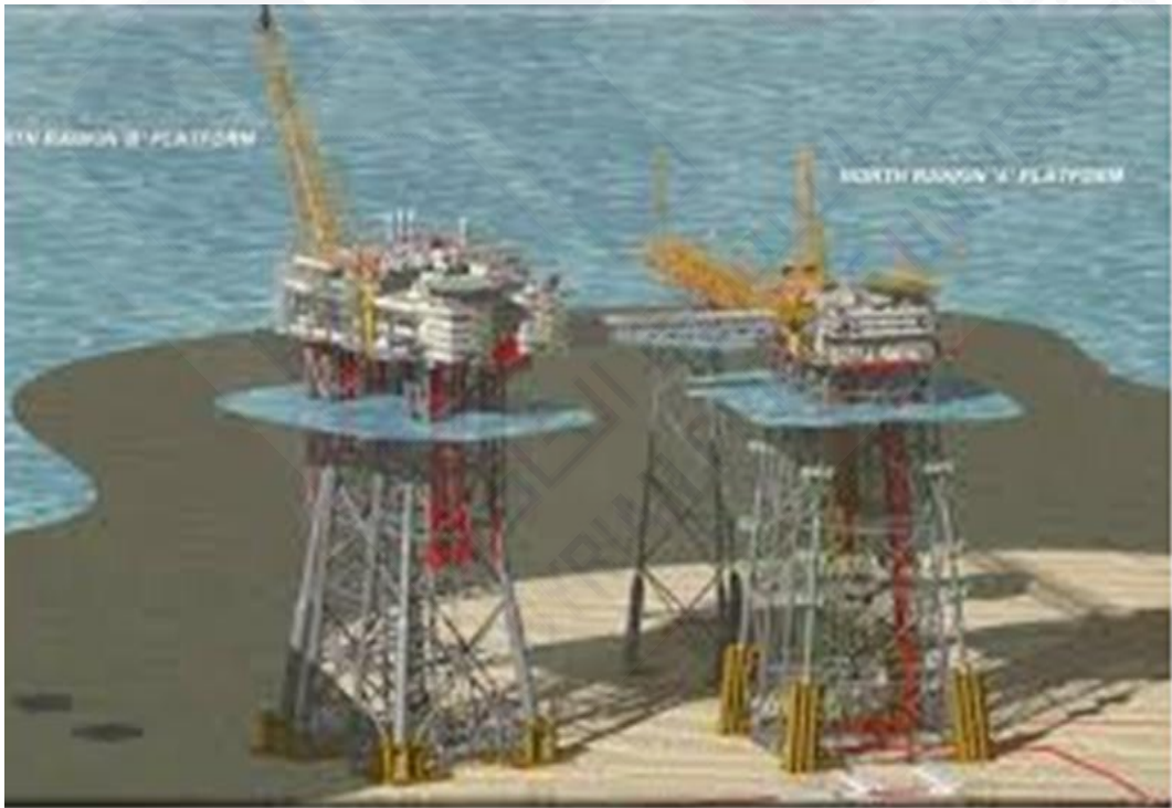
الشكل (1-4) منصات بحرية ثابتة بشبكة متصالبة من الانابيب المعدنية
